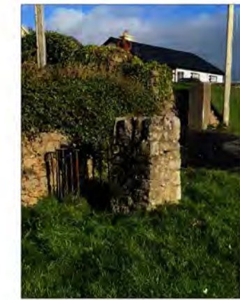
A. EXISTING GATE
